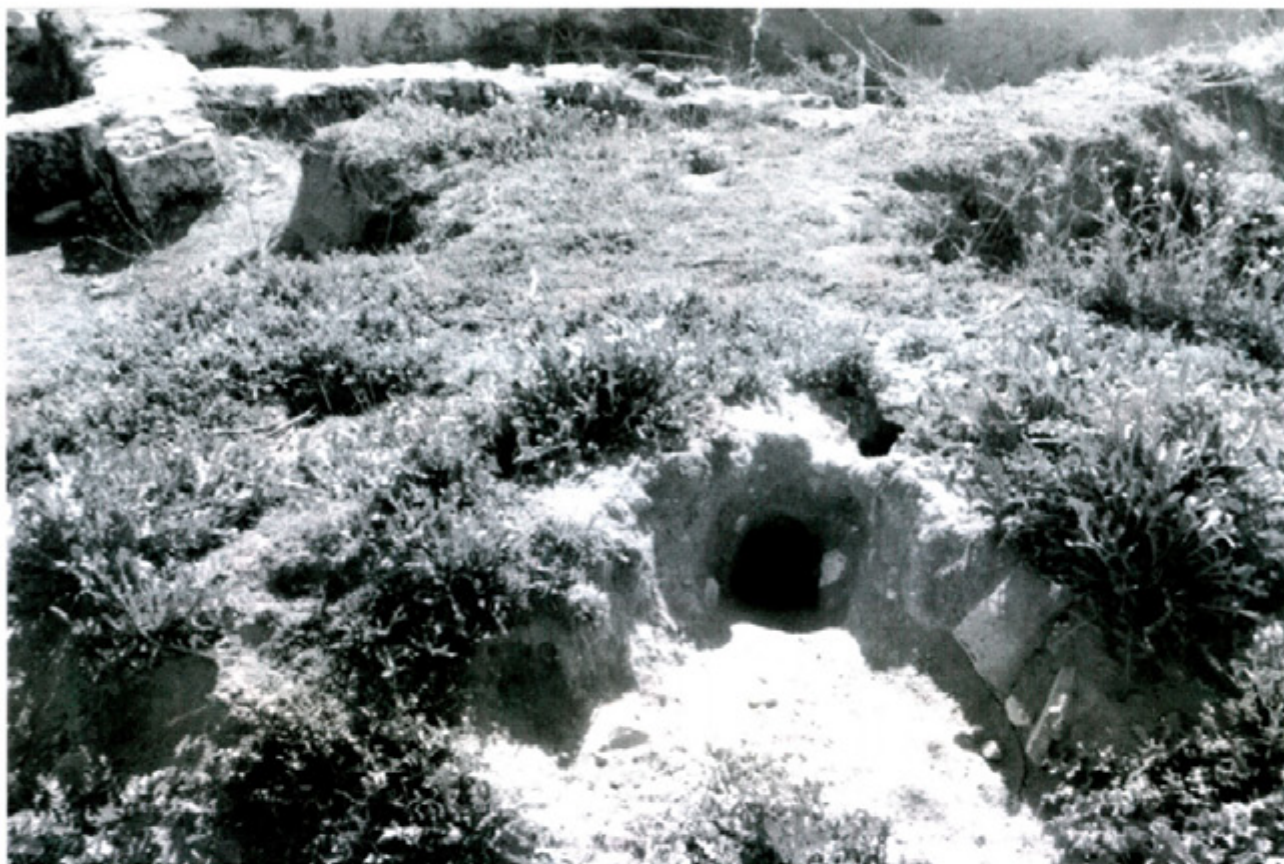
Lámina IX. Deterioro por realización de cuevas de roedores
