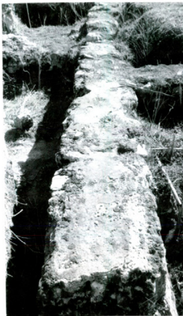
Lámina VI. Conjunto de líquenes sobre argamasas en cota superior de los muros. Deterioro consecuente
