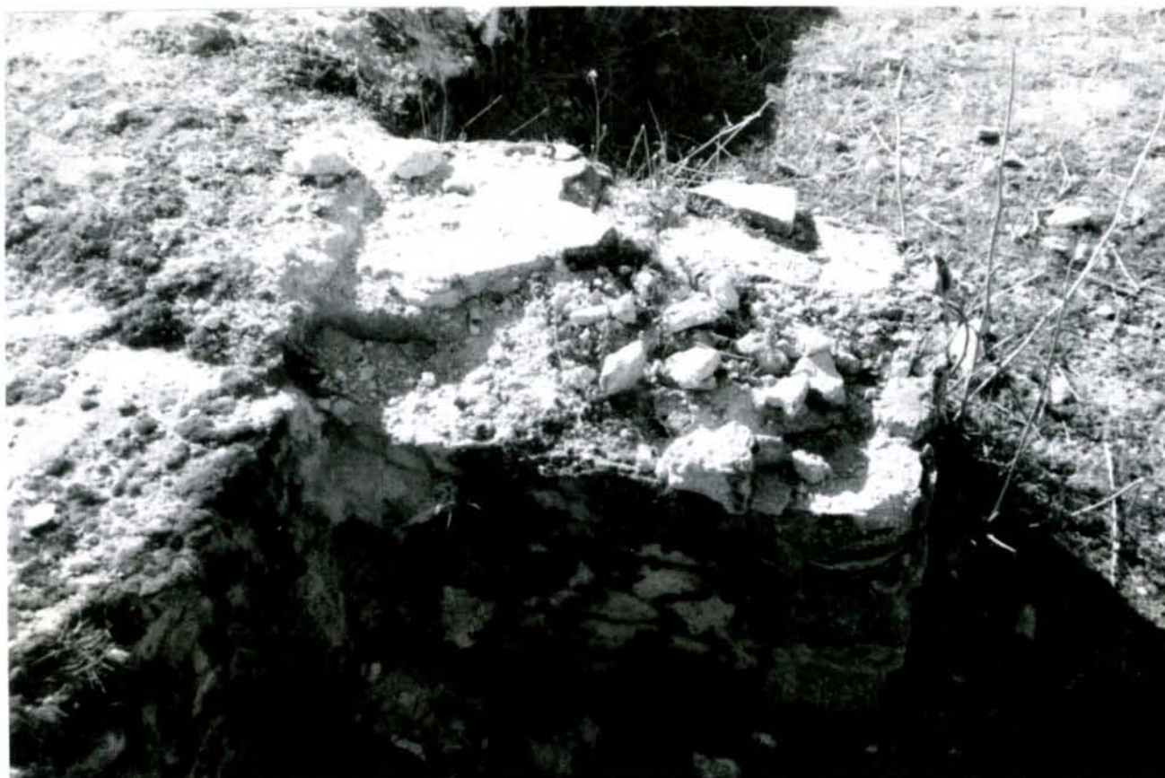
Lámina III. Desprendimiento de argamasa de cal en la parte alta de los muros, en forma de planchas
