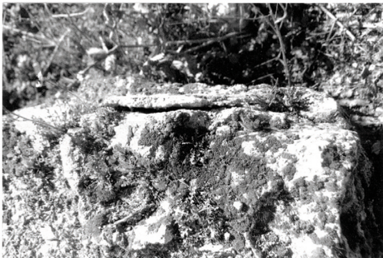
Lámina VIII. Degradación de los revocos de cal, con pérdida de adherencia al soporte del muro
