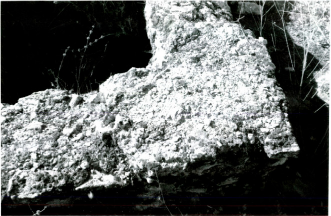
Lámina IV. Destrucción por hielo de la argamasa de cal sobre un muro
