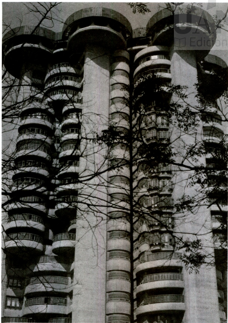
FRANCISCO JAVIER SAENZ DE OIZA: Torres Blancas en Avenida de América-calle Corazón de María. 1960-65/1965-68. Materialización definitiva de la obra.
