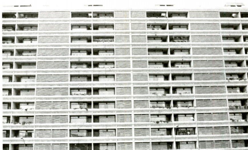
JOSE LUIS GONZALEZ CRUZ: Viviendas en calle Beatriz de Bobadilla, 13-15. 1972-75. Racionalización extremada y precisión modular en un bloque que, aun recordándonos a Le Corbusier, está al margen del carácter expresivo y escultórico o investigador de éste (modular), para ajustar ordenadamente unos mínimos espaciales.
