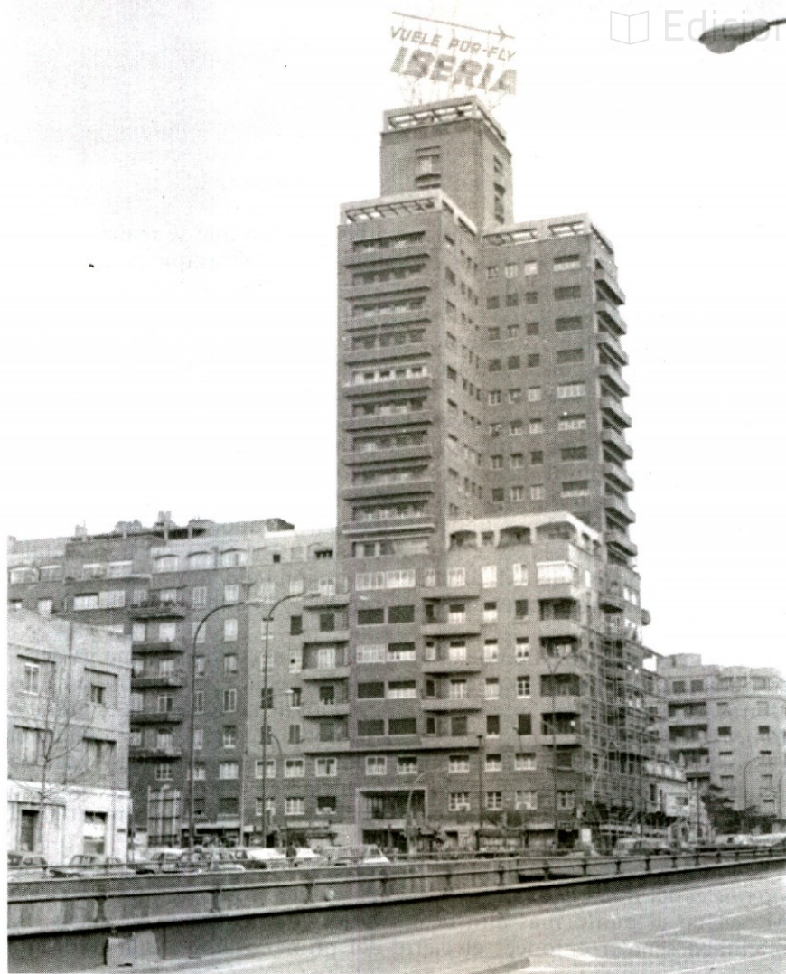
GONZALO E IGNACIO DE CARDENAS: Edificio Bancaya en Avenida de América c/v Francisco Silvela. 1949-53. Adaptación del rascacielos internacional para viviendas en altura.
