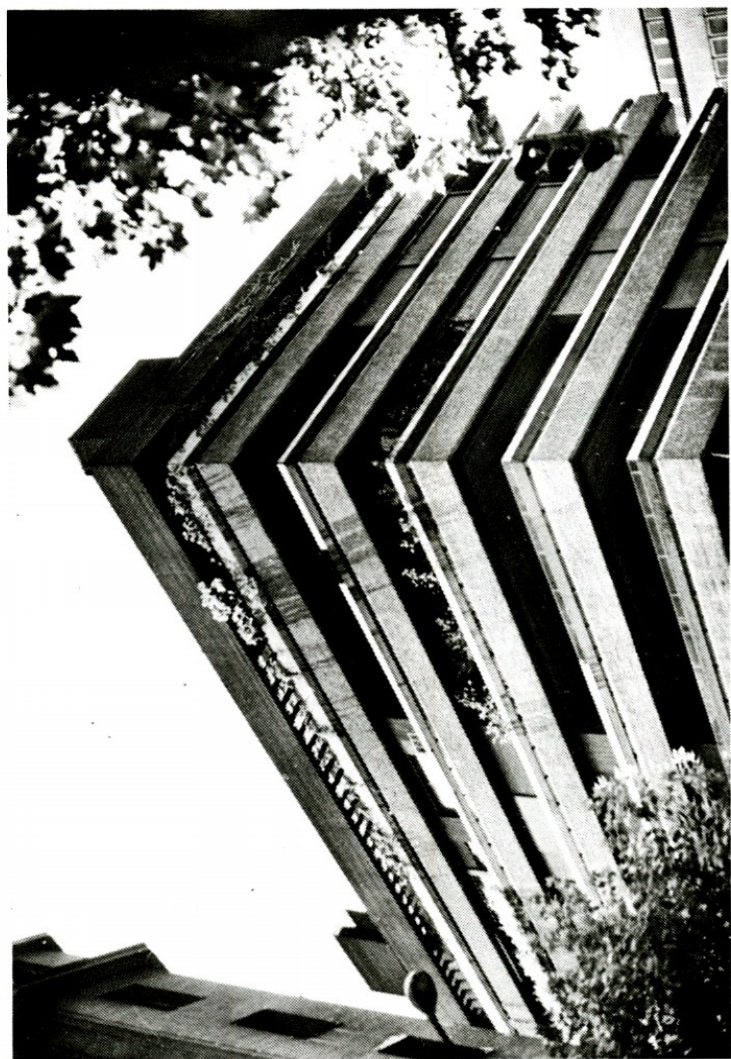
JUAN MANUEL RUIZ DE LA PRADA: Viviendas en Paseo Martínez Campos c/v Zurbano. 1964-66. Enlace con el «Estilo Gutiérrez Soto» en un nuevo estadio evolutivo de la vivienda madrileña, respeto de las pautas de confort modernas (escala humana, líneas predominantemente horizontales, racionalización de espacios, etc.), incorporación silenciosa a la ciudad, tratamiento cuidado del tradicional ladrillo, uniformidad a la calle de un producto heterogéneo, buen acabado, integración de las artes... participación en el régimen de promoción.
