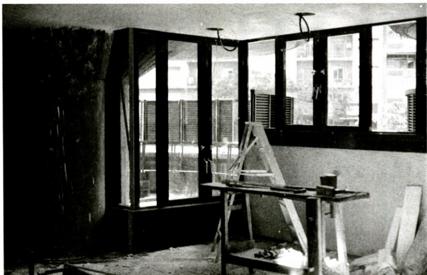
FRANCISCO JAVIER SAENZ DE OIZA: Torres Blancas. Salón-terraza. Valoración de la textura bruta del hormigón en arquitectura interior.
