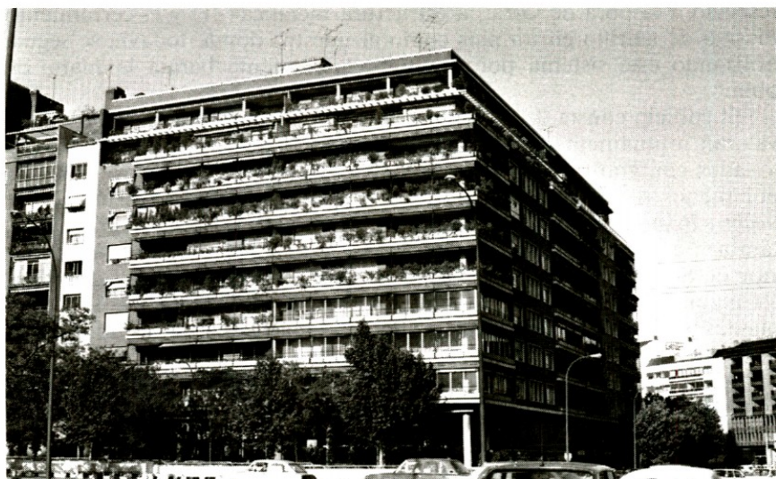
LUIS GUTIERREZ SOTO: Viviendas en Paseo de la Castellana, 124. 1953. Consumo y definición del «Estilo Gutiérrez Soto» más genuino: composición de un bloque armonioso, según las ordenanzas, mediante basamento pétreo; cuerpo intermedio de amplias terrazas corridas y superpuestas con los característicos «brise-soleil» metálicos horizontales o toldos; áticos retranqueados, etc., elementos que, por sí mismos, definen la fachada.
