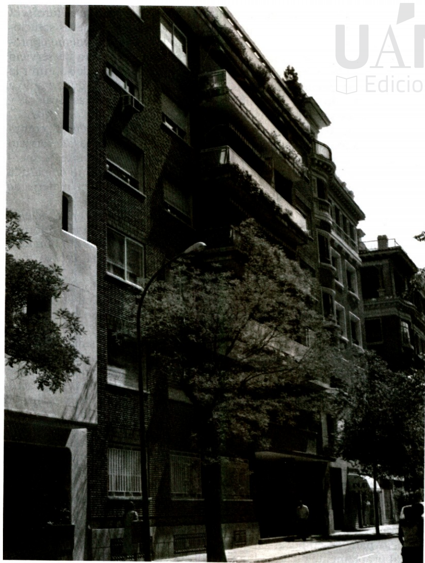
LUIS GUTIERREZ SOTO: Viviendas en calle Jorge Juan, 37. 1952. Edificio paradigmático: revolución en el desarrollo del portal, comunicaciones propietarios/servicio; zonificación estancias día/noche o deslinde de estancias propietarios/servicio. Dentro de un programa muy complejo dadas las necesidades de una alta burguesía propia del barrio de Salamanca.
