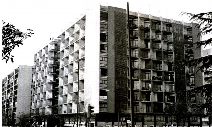
ANTONIO LAMELA: Viviendas en Paseo de la Castellana, 121. 1957-59. Adecuación al tipo de manzana del ensanche en esta zona. Tratamiento preferente del problema de la luz solar en el quiebro y ritmo zigzagante de fachada. Atrofia definitiva de la confortable terraza «Estilo Gutiérrez Soto».
