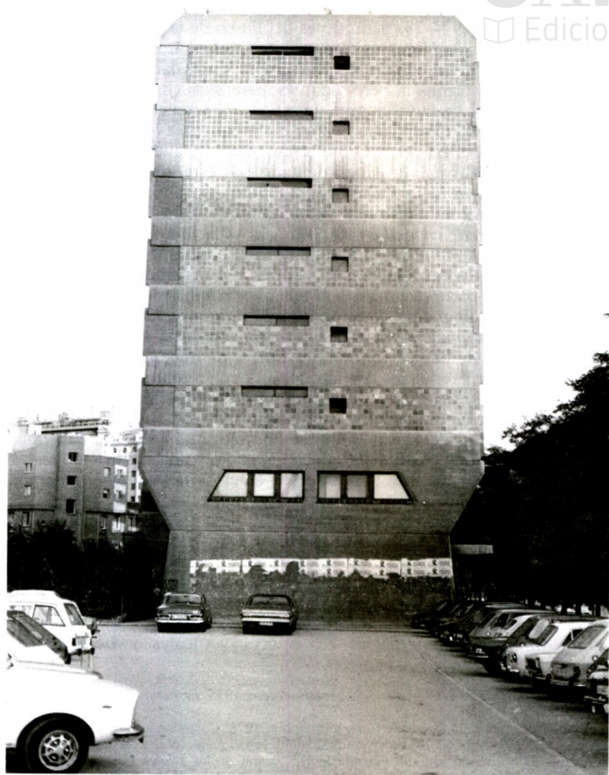
JOSE LUIS GONZALEZ CRUZ: Viviendas en la Avenida del Doctor Federico Rubio y Gali, 87-91. 1968-70. Combinación del hormigón con la plaqueta de gres.
