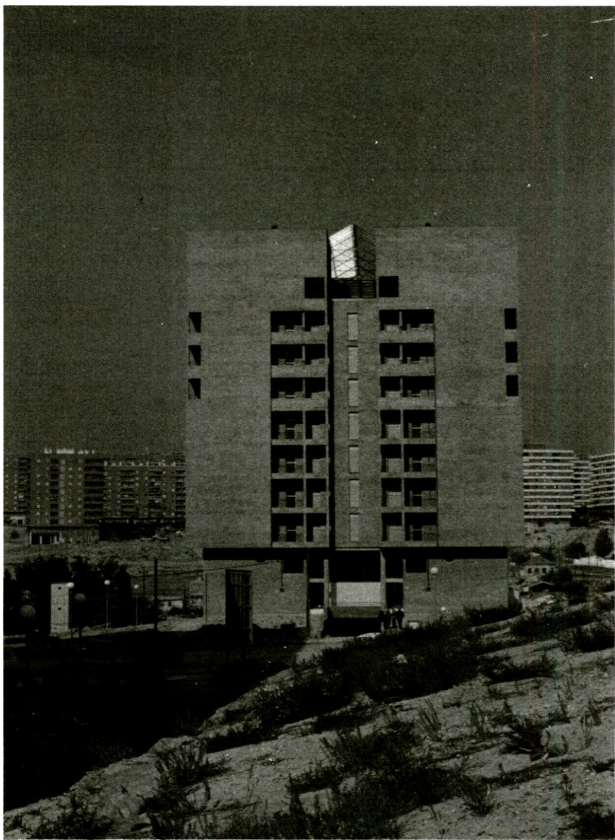
«Estudio Dos» (CARMEN BRAVO, PILAR CONTRERAS, JAIME MARTINEZ, JOSE LUIS DE MIGUEL): Viviendas «Peña Chica» en calle La Bañeza (barrio del Pilar). 1977-82. Pérdida de las pautas de confort, prevalencia del diseño sobre la función, adiós a la arquitectura moderna.
