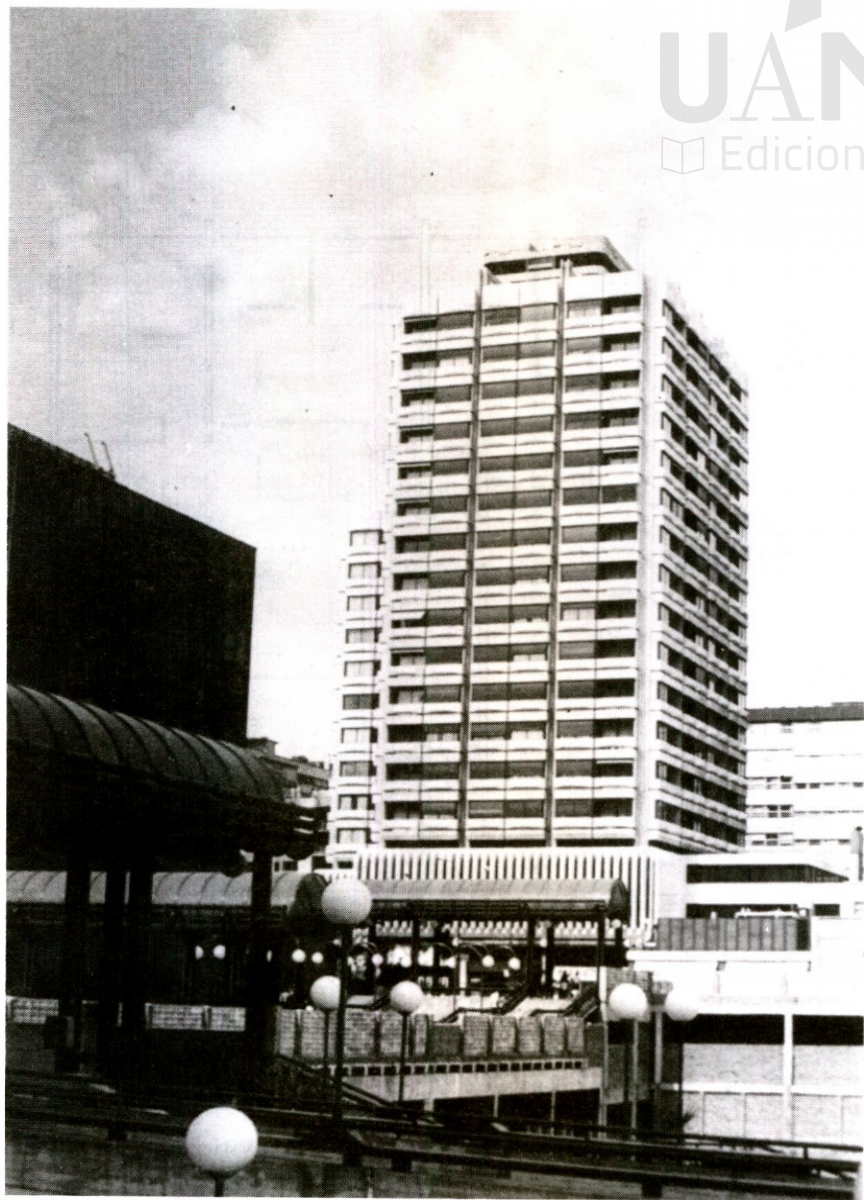
J. L. GONZALEZ CRUZ: Apartamentos en c/ Orense, 6. 1974-76. Espacios mínimos para habitantes sin grandes familias y con gran movilidad o independencia. Integración de elementos prefabricados de hormigón (petos) en fachada.
