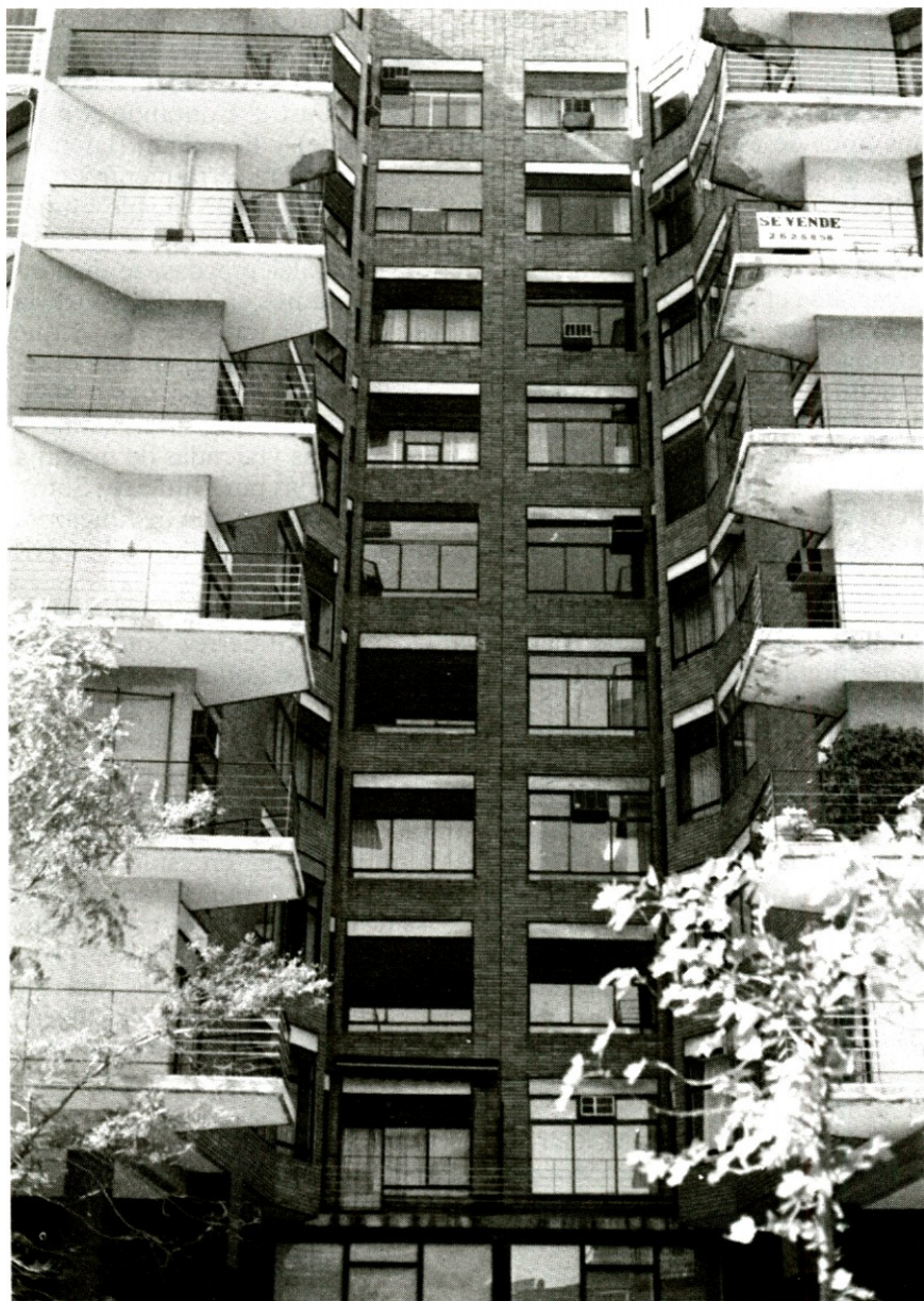
ANTONIO LAMELA: Viviendas en Paseo de la Castellana, 121. 1957-59. Accesos a portales de entrada y a garajes en nivel inferior. Problemas de intimidad insolubles.
