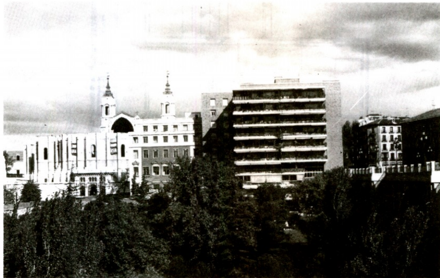
FERNANDO MORENO BARBERA; JUAN GOMEZ GONZALEZ DE LA BUEGA; JULIO CANO LASSO; RAFAEL DE LA JOYA: Viviendas en la calle Bailén, junto al viaducto. 1958-62.
