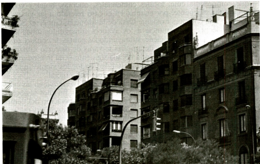
LUIS GUTIERREZ SOTO: Viviendas en calle Miguel Angel, 2-6. 1936-41. Adaptación del característico «bow-window» anglosajón o mirador poligonal tipo Chicago a los bloques de viviendas madrileños.
