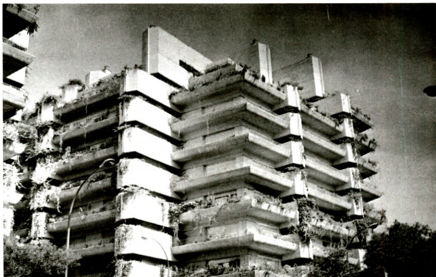
FERNANDO HIGUERAS Y ANTONIO MIRO: Viviendas en la Glorieta Ruiz Giménez-calle San Bernardo. 1970-75. Detalle de terrazas-bandejas que permiten la incorporación de jardineras con plantas colgantes.
