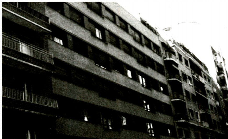
ANTONIO FERNANDEZ ALBA: Viviendas en calle Hilarión Eslava, 48. 1959-60. Obra silenciosa, anónima, respetuosa con el entorno preexistente. Su asepsia y frialdad racionalistas aparentes quedan contrarrestadas con una sutil calidad de diseño en fachada y con la utilización de materiales y técnicas artesanales.
