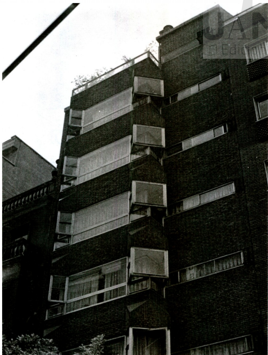
ANTONIO VAZQUEZ DE CASTRO: Viviendas en calle Ayala, 134. 1965-66. Incorporación a la zona mediante el impecable trabajo del tradicional ladrillo bien aparejado. Elaboración artesanal no exenta de ribetes tecnológicos (estructura metálica, carpintería de aluminio), expresivos y lógicos (aprovechamiento de la escasa luz) en los miradores que rompen el plano de fachada.
