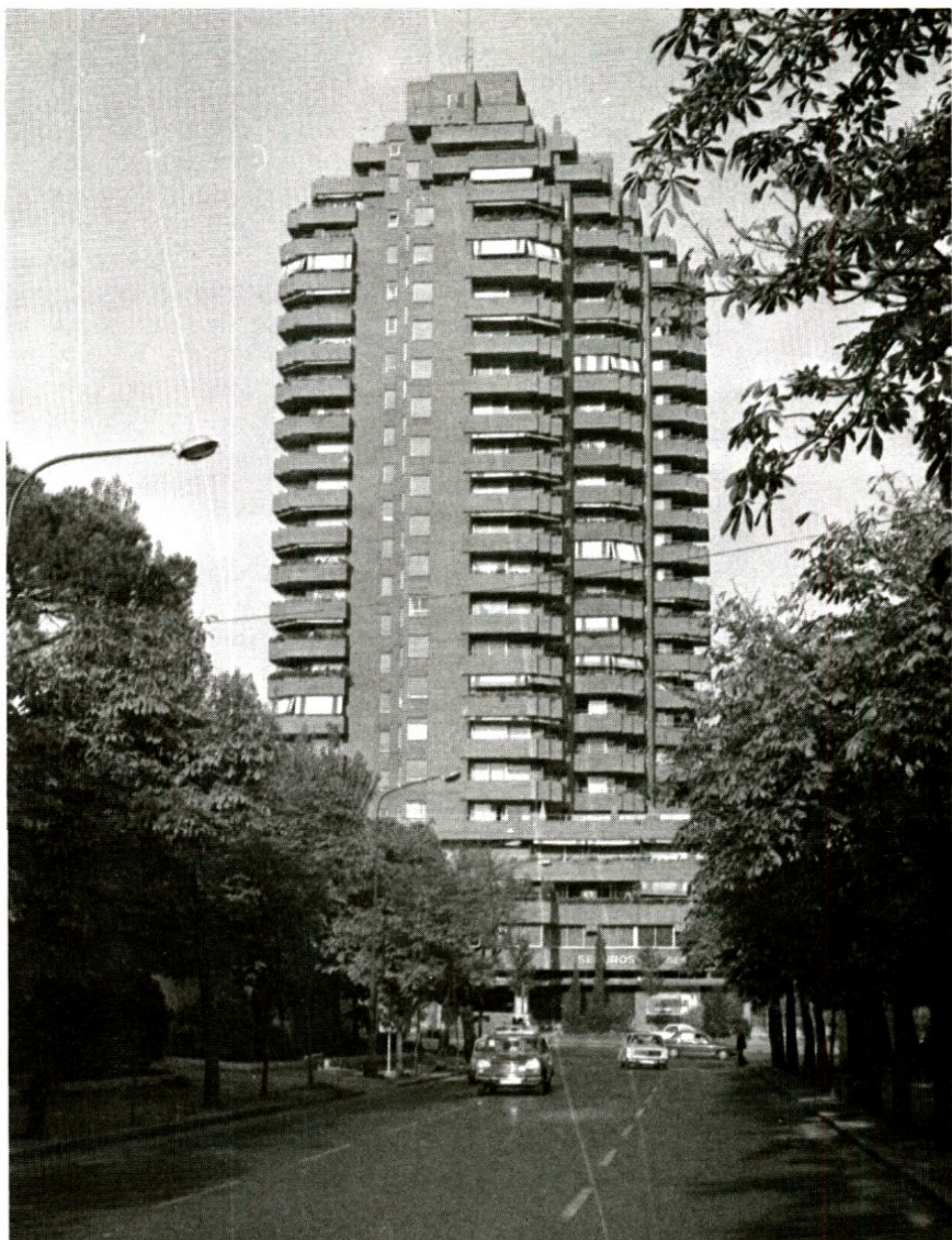
LUIS GUTIERREZ SOTO Y EUGENIO GUTIERREZ SANTOS: Torre del Retiro en Avenida Menéndez y Pelayo, 67. 1969-71. Utilización de la estructura metálica en un edificio excepcional de gran altura; pero mantenimiento, en el cierre del mismo, del cálido ladrillo de marcado carácter artesanal en un país donde resultaba relativamente barata la mano de obra. El edificio se abre mediante un esquema dentado que garantiza las mejores orientaciones respecto al sol y las mejores vistas.
