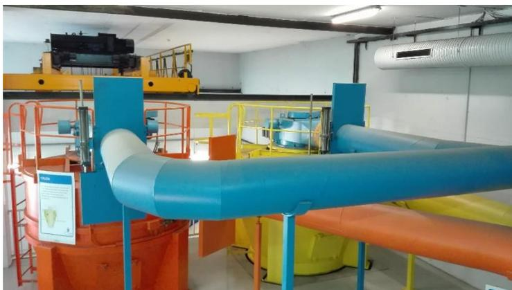
*Imagen 8 Interior del centro de recogida neumática de residuos del barrio de Fuentelucha (Alcobendas)*
