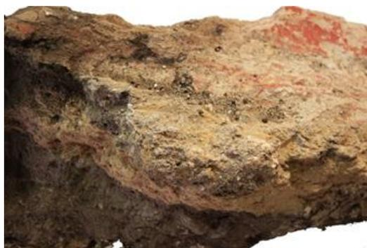
Fig. 33. Arenización, pulverulencia y erosión de los bordes del bloque de la caja 3 de los arranques murales del Yacimiento Vacceo de Cuéllar (fotografía octubre 2016)
