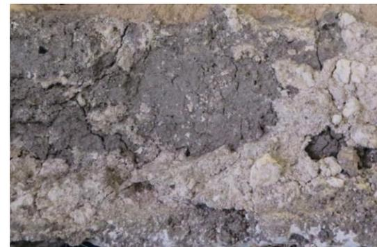
Fig. 37. Fisuras en los estratos de mortero en el bloque de la caja 2 de los arranques murales del Yacimiento Vacceo de Cuéllar (fotografía octubre 2016)
