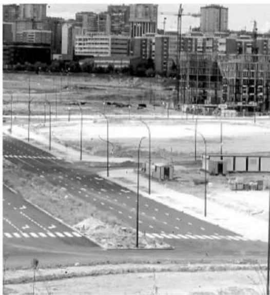
Las obras de urbanización están al 75 por ciento
