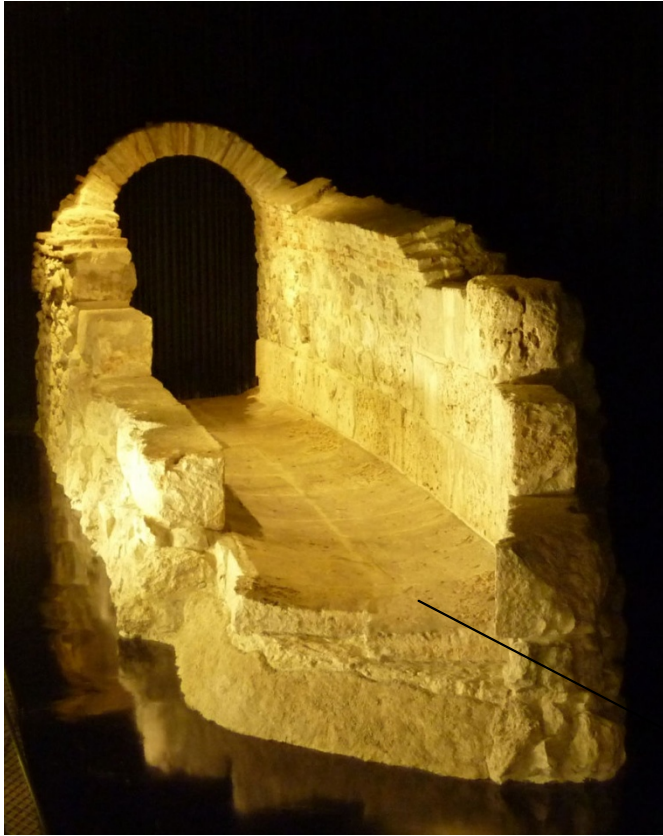
Picado de la alcantarilla
