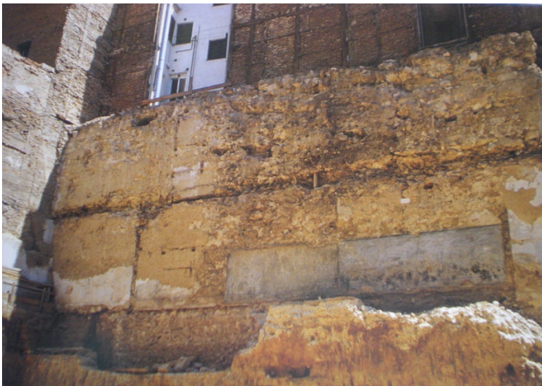
Fig.26: lienzo de muralla de la Cava Baja 30. Fotografía tomada de Fernández Ugalde (1998).
