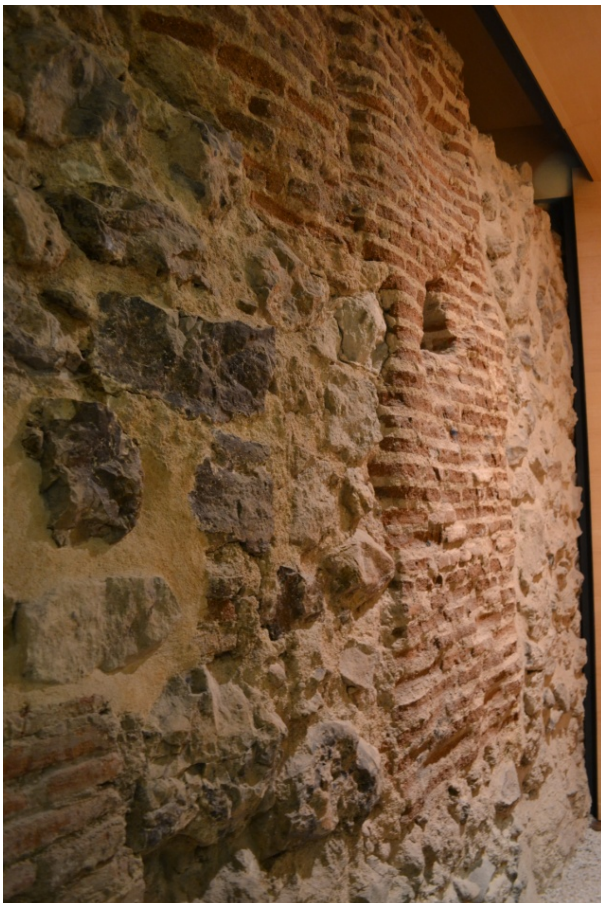
Fig.19: Extremo derecho del lienzo donde encontramos un revestimiento de ladrillo.
