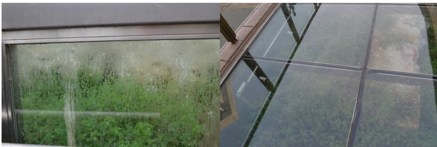
Fig.41: La proliferación de vegetación está tan extendida que muy difícil entrever los restos, con la dificultad añadida de la condensación del agua.
