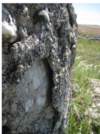
Fig. 193. Desprendimiento revoco
