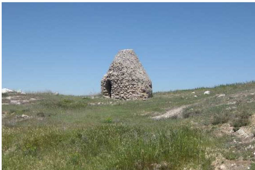
Fig. 58. Vista sureste. Chozo de El Portillo. Fotografía de la autora.
