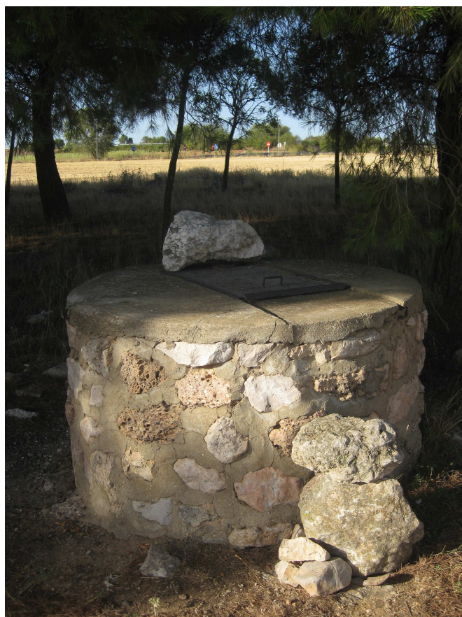
Fig. 96. Pozo Pijón. Fotografía de la autora.
