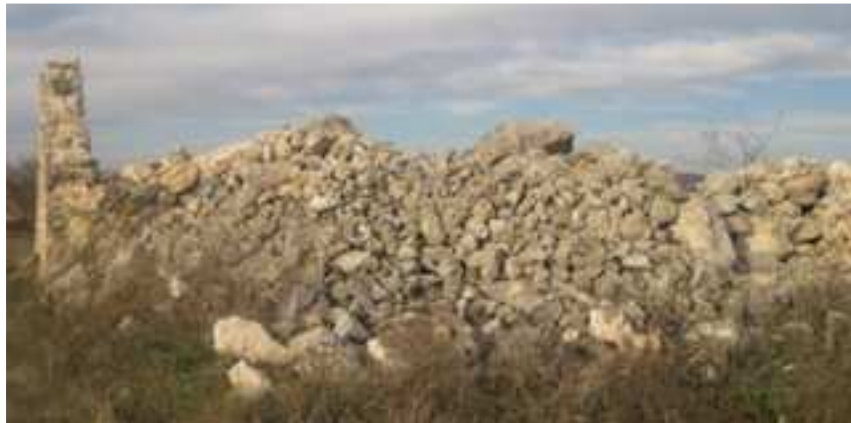
Fig. 218. Vista Sur. Fotografía de la autora.
