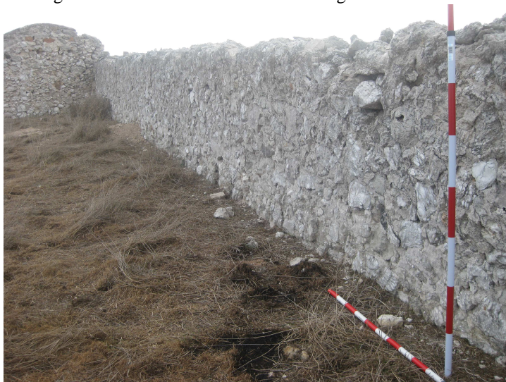
Fig. 78. Choza de La Huerta Orea. Muro Oeste. Fotografía de la autora.
