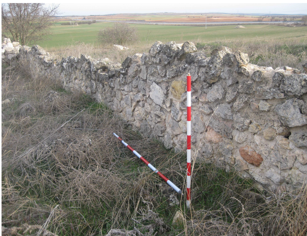
Fig. 227. Fachada Sur, corral del Tío Régulo. Fotografía de la autora
