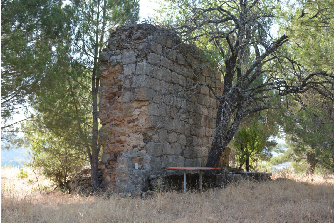
1. Muro de la Iglesia de Santa María de Tórtoles, donde se sitúa la posible puerta de acceso (© Elisa Ruiz-Tagle 2022).
