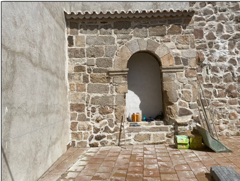
Figura VII. Fotografías del arco (puerta) recientemente descubierto en la calle del Coso nº 30, antes y después de su restauración (©Alfredo Escudero 2022)
